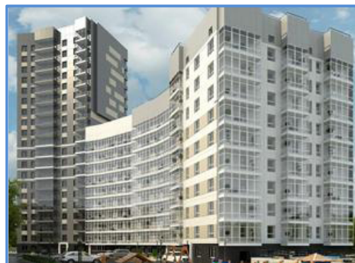
Жилой комплекс в Перми
