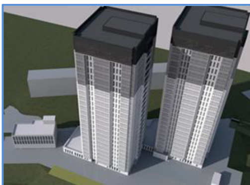
Жилой комплекс в Перми
